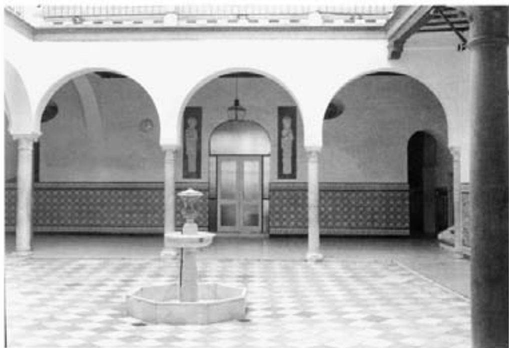
El patio principal, con las galerías recuperadas. 1961
